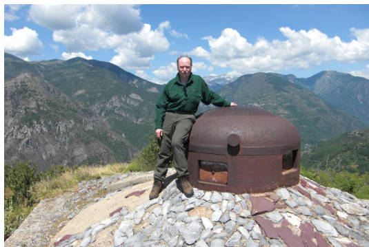
Cor op Gros Ouvrage de Rimplas, een werk van de Maginot linie in de Franse Alpen.
