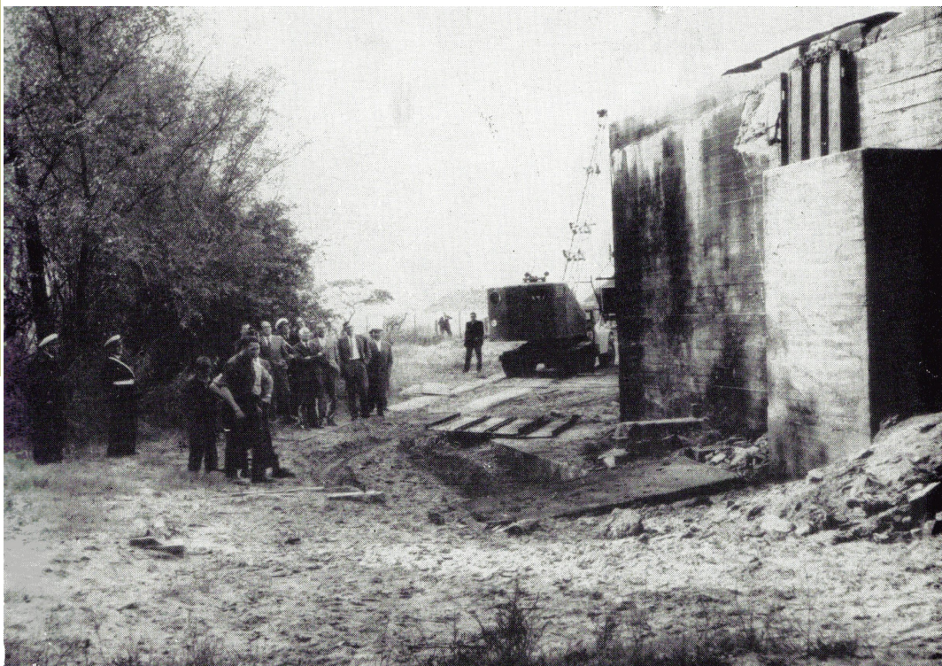
(Sloop communicatiebunker van het type R 616 op het landgoed "Offem")
